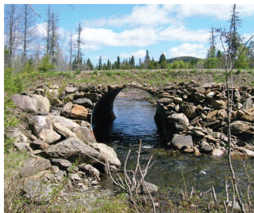
Exemple d'un ponceau bien aménagé
